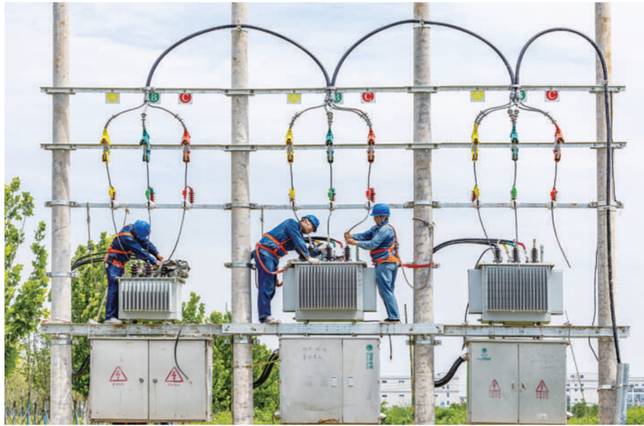
在安徽省亳州市谯城区合欢东路施工现场,国网亳州供电公司施工人员正在安装变压器,助力亳州高新区经济发展。
