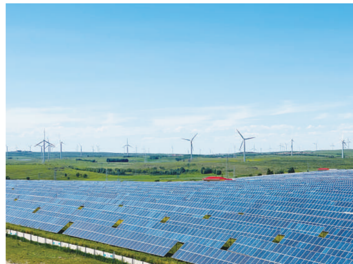
图为张北国家风光储输示范工程一角。 资料图片
