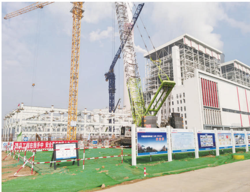
图为国能神华九江电厂二期扩建工程施工现场。
