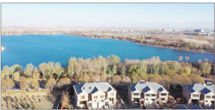
图为2023年11月24日,中央生态环境保护督察组现场督察发现,芦苇湾景区建有取水工程。
