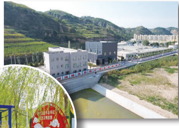
▲吕梁市临县污水处理厂入河排污口自动监测站
