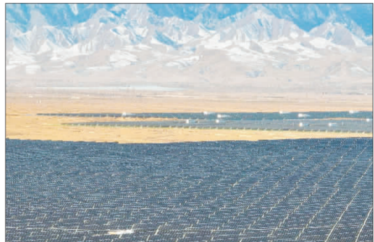
甘肃省张掖市甘州区甘州南滩30万千瓦光伏发电项目,绵延七千亩的深蓝色“绿色海洋”蔚为壮观。据了解,这个项目是张掖市“十四五”第一批风电光伏竞争性配置项目,也是截至目前张掖市建成的单体规模最大的集中式光伏发电项目。 人民日报网供图
