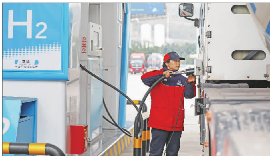
在重庆市长寿区一家供氢中心，工作人员在为氢燃料卡车加氢。这一供氢中心以工业化生产的富余氢气作为原料，利用提纯技术，每天可向社会供应高纯氢6400公斤，可满足260辆氢燃料车物流重卡用氢需求。 人民图片网供图
