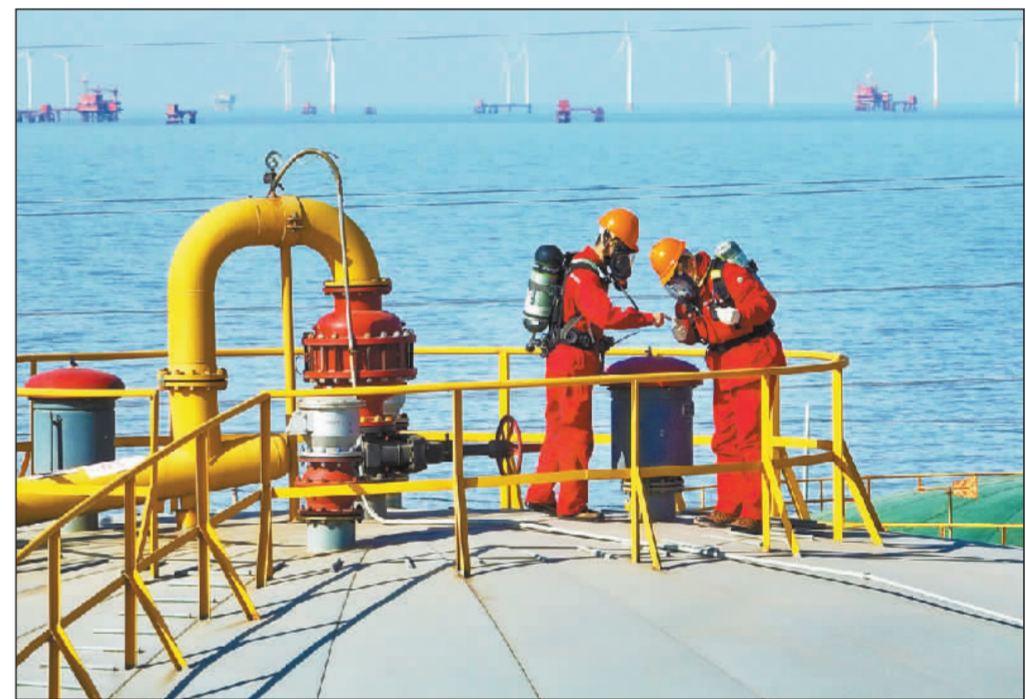
山东省东营市的胜利油田近年来高标准落实黄河流域生态环境保护专项整治措施,开展了“无废油田”和绿色工厂创建,实现了石油开采、运输和储存的全过程清洁生产。图为在胜利油田海四联合站,员工对储油罐顶部液压安全阀和机械呼吸阀进行维护,避免甲烷等气体外排造成大气污染。
